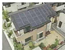
■ 太陽光発電システム
