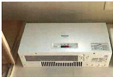
太陽光発電のパワコンには、停電時などに電気が使えるコンセントがついている。別途工事により壁などに非常用コンセントを設けることもできる（写真：エコワークス）
