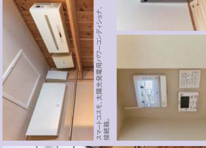
スマートホーム、太陽光発電用パワーコンディショナ、線絡箱。
